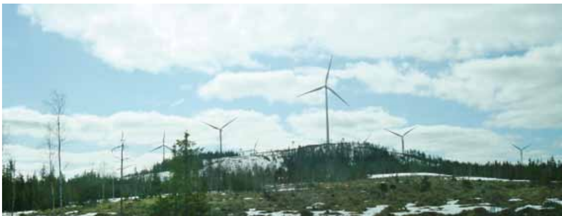
Röbergsfjället i Vansbro kommun, där åtta stycken 2 MW-vindkraftverk byggs; 80 meter höga, 90 meter rotordiameter. Foto: Anders Ljunggren.
