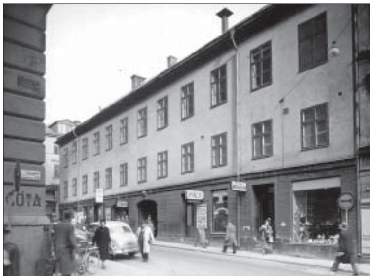
Modellkammarhusets fasad mot Mäster Samuelsgatan. Huset var akademiens huvudbyggnad under åren 1863–1954. Fastigheten bestod av fyra trevåningslängor kring en gård till vilken ett portvalv ledde från Mäster Samuelsgatan. Bottenvåningen hyrdes ut till butiker; på mellanvåningen låg bl.a. biblioteket och högst upp låg sessionssalen, sammanträdesrummet och kansli-lokalerna med sekreterarens rum. Foto Lennart af Petersens 1954, Stockholms stadsmuseums arkiv.
