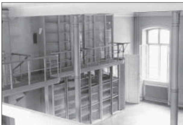
Stora föreläsningssalen en trappa upp, akademiens nuvarande kollegierum 1970. I linje med gjutjärnskolonnerna fanns ursprungligen en mellanvägg och utmed väggarna fanns smala gallerier. Dokumentationsfotografi inför rivningen av interiören. Foto i KSLA:s arkiv.
