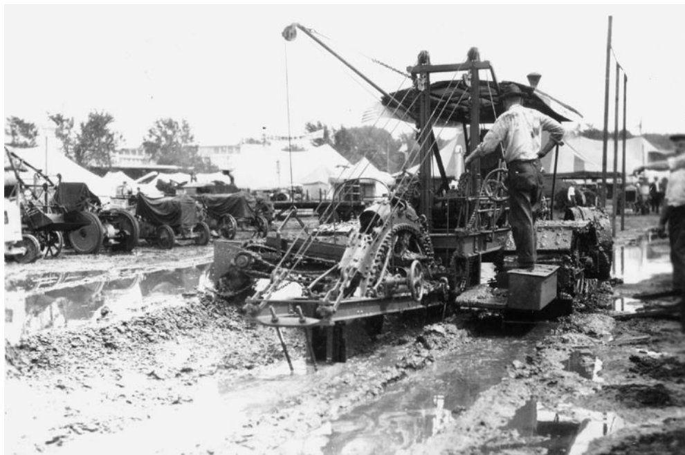
Ett av många fotografier ur Nils Berglunds arkiv. Bilden är tagen i augusti 1922 under Berglunds studietid i USA och föreställer dikesgrävningsmaskinen "Buckeye", senare populär även i Sverige, i aktion under en utställning i Des Moines.
