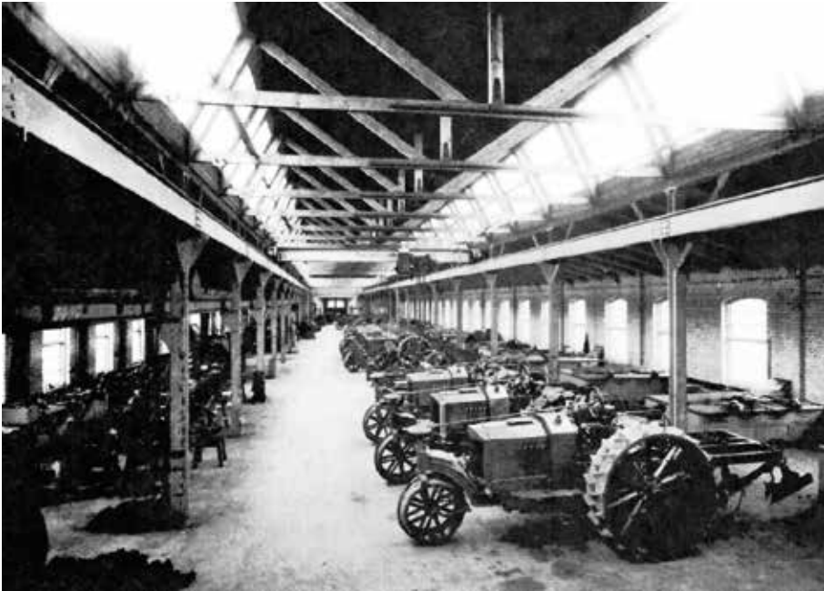
Bild 5:4. Motorplogen June. Den nyuppförda verkstadshallen i Bankeryd där montering pågår av ett tjugotal motorplogar ca 1919–20.
