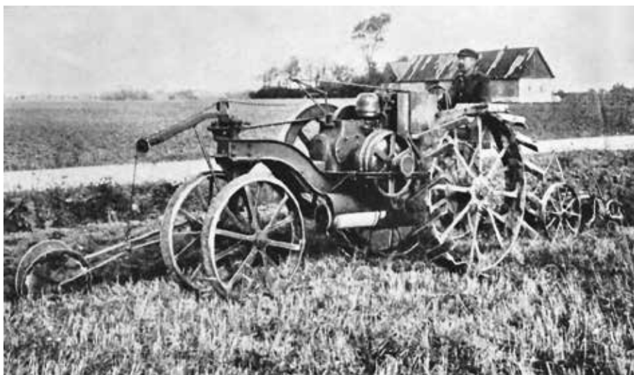
Bild 5:5. IH Mogul 8–16 hk i arbete 1916 på Arlövsgården, Skåne. Märk den s.k. styrpiloten som underlättar plöjningen då traktorn inte går med något hjul i färan.
