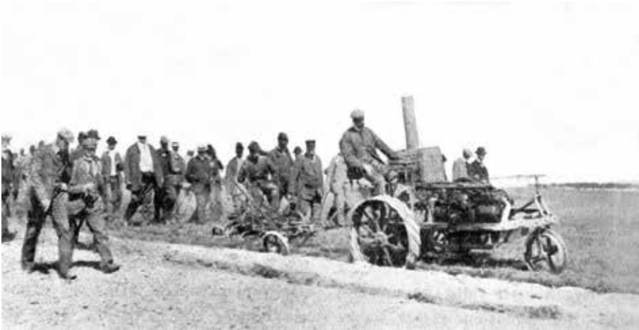
Bild 5:2. Den första demonstrationen i Sverige av The Ivel sägs ha ägt rum på Alnarp 1905. Plogen är av typen "riding-plough" som manövreras av mannen som sitter på den. Foto i Skånsk Jordbrukstidskrift 1919.
