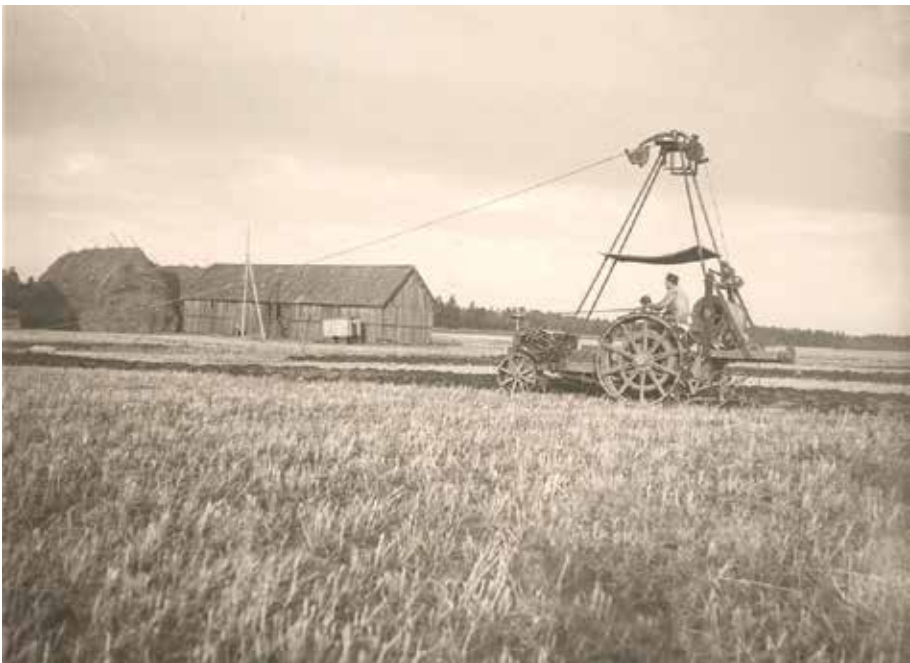
Bild 2:3. Asea/Junes elektriska plog under provkörning vid Nordanby gård utanför Västerås 1923. Foto ur Svenska Motokulturföreningens arkiv, KSLA.
