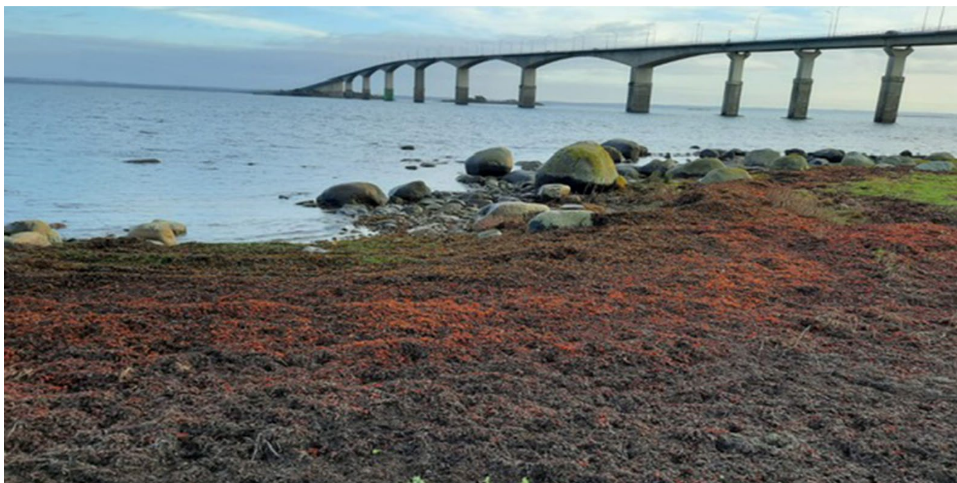
Foto: Varvara Sachpazidou
