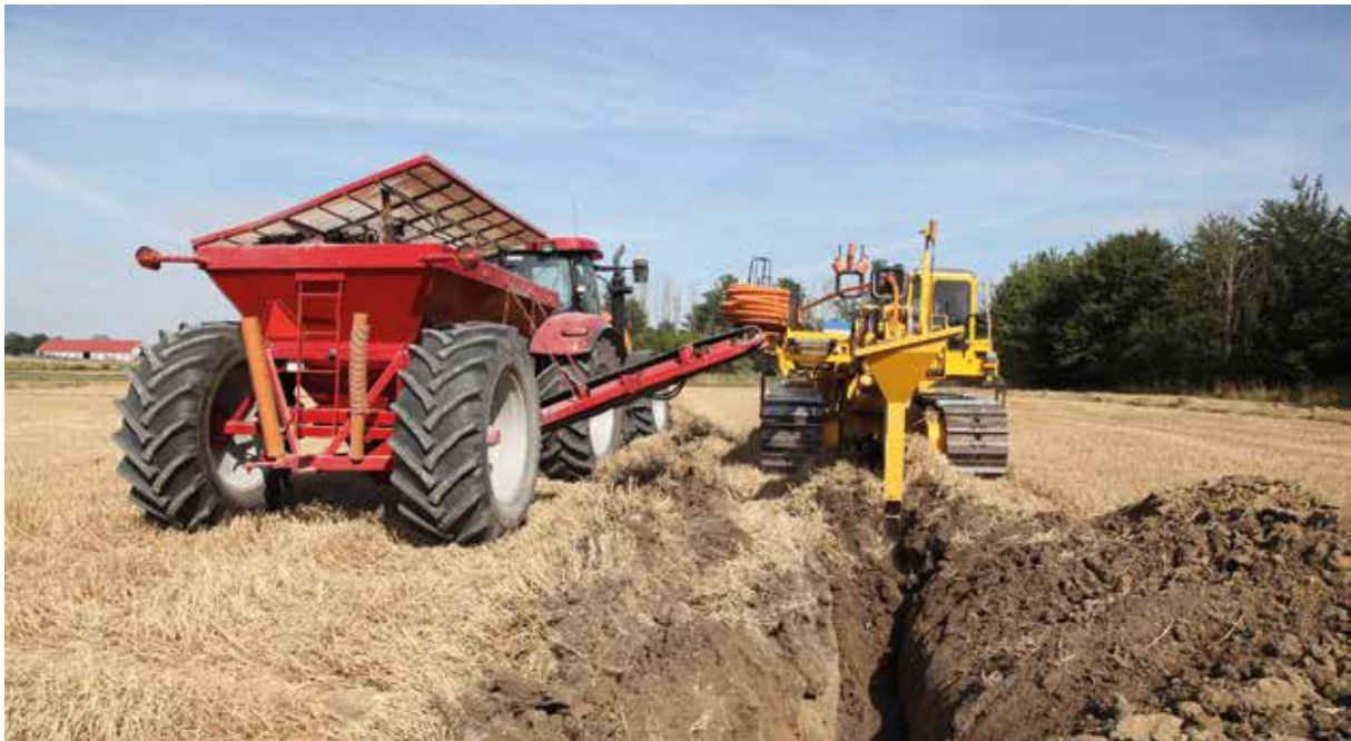
Behovet av ny- och omdränering i Sverige ligger kring 10 000 hektar per år, men bara ca hälften av det behovet åtgärdas. Dräneringsskulden ökar därmed och dräneringstakten behöver dubblas. Foto: Jens Blomquist.
