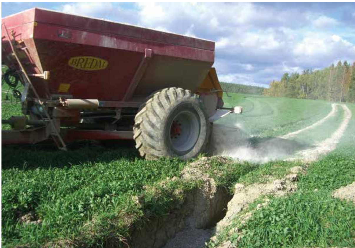
Kalkinblandning i täckdikesåterfyllnaden är ett sätt att minska risken för fosforförluster, och är också ett av leden i dräneringsförsöket utanför Sala. Foto: Jens Blomquist
